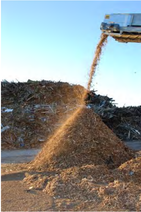
Bilde 17. Høvellast i avhendingsfasen, treavfall kvernes før forbrenning Foto: Kjersti Folvik
